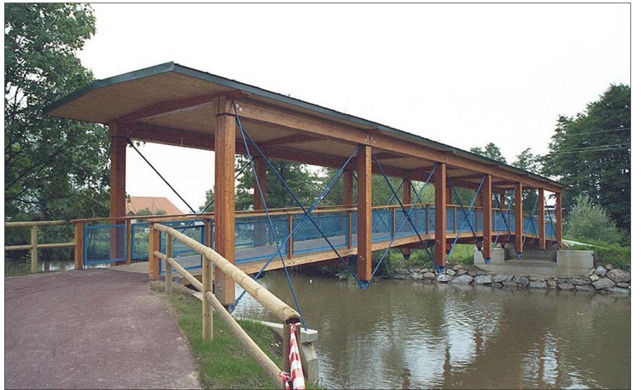
Brücke in der Steiermark (Österreich)
