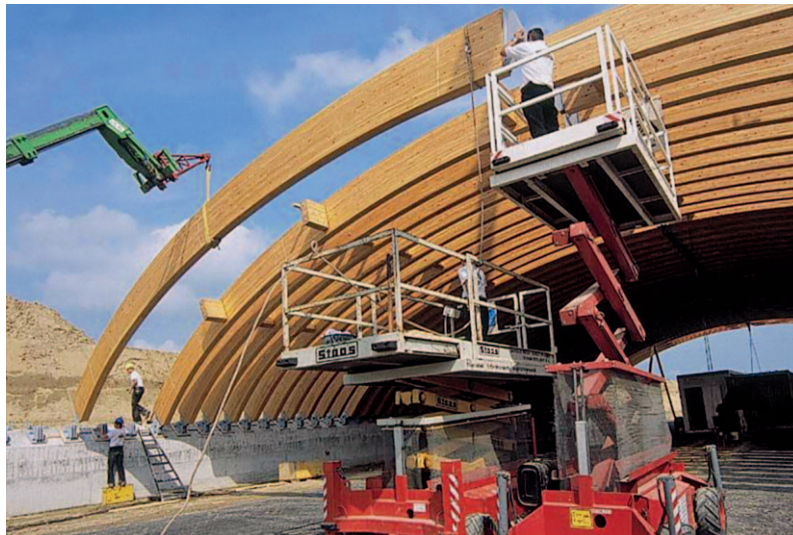
Montage der Brettschichtbinder an der Grünbrücke Wilmschagen.
