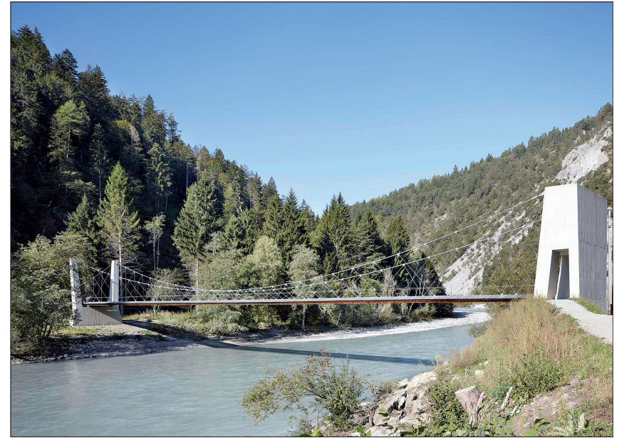
... überspannt im Kanton Graubünden den Vorderrhein. Sie entstand nach den Plänen des Ingenieurbüros Walter Bieler aus Bonaduz und kombiniert die Baustoffe Holz, Stahl und Beton. Fotos (2): Ralph Feiner
