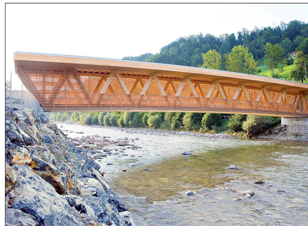
Die Fachwerkträger-Schwerlastbrücke über den Fluss „Kleine Emme“ erhielt eine offene horizontale Lamellenschalung sowie ein einseitig auskragendes Dach zum Schutz vor Bewitterung.
