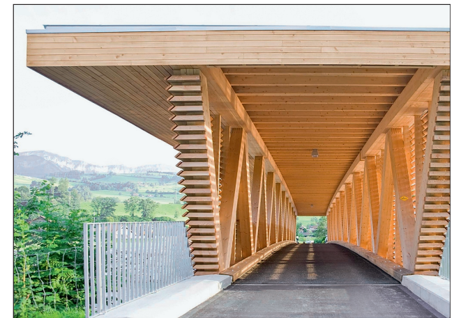
Der Ersatzneubau lehnt sich an die Bautradition überdachter Brückenbauwerke an. Die einspurige Fachwerkträgerbrücke hinterlässt aber einen etwas schwerfälligen Eindruck. Fotos (2): Pirmin Jung Ing.
