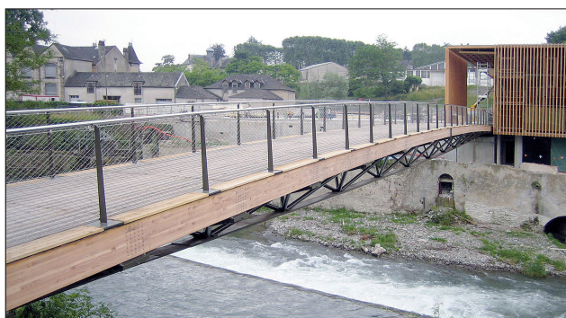
Fußgängerbrücke in Oloron Ste. Marie (Frankreich): Materialeffiziente BS-Holz-Stahl-Verbundkonstruktion für große Spannweiten. Foto: Schaffitzel
