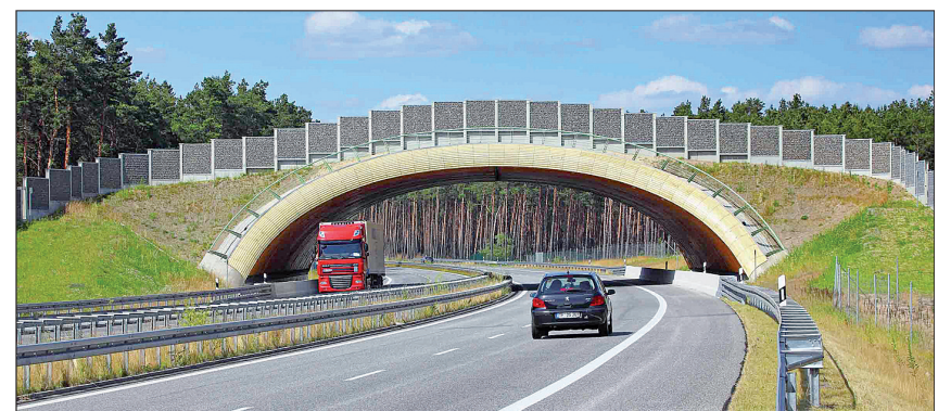
Wiesenhagen: Der Brückenbogen leitet die Lasten ideal ab und formt das für den Straßenverkehr erforderliche Lichtraumprofil. Fotos (2): Schwesig und Lindschulte
