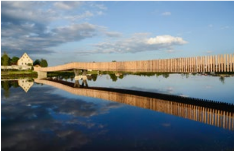
Keine Auszeichnung für die Max-Gleissner-Brücke im oberpfälzischen Tirschenreuth . Die Jury sah erhebliche Mängel beim baulich-konstruktiven Holzschutz; Architektur: Annabau Berlin, Tragwerksplanung: Schüssler Plan, Berlin.
