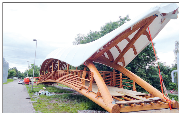
Die Kunstholzbrücke wurde als ganzes vormontiert und eingehoben. Die unteren Bögen dienen der Aufnahme der Zugkräfte, die oberen nehmen die Druckkräfte auf. Konstruktiven Holzschutz bieten die Membran sowie kleine Abflusskanäle wie etwa an den „Bogenstößen“. Foto: Jan Stelcl/SJB
