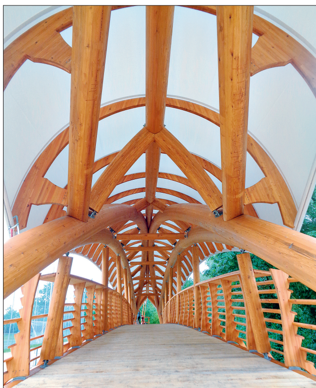
Das Haupttragwerk der Kunstholzbrücke „Aubrigg“ in Opfikon (Schweiz) bilden zwei gegeneinander gelehnte Brett-schichtholz-Bögen und Konstruktionshölzer aus Lärche, überspannt von einem Membrandach. Foto: Jan Stelcl/SJB
