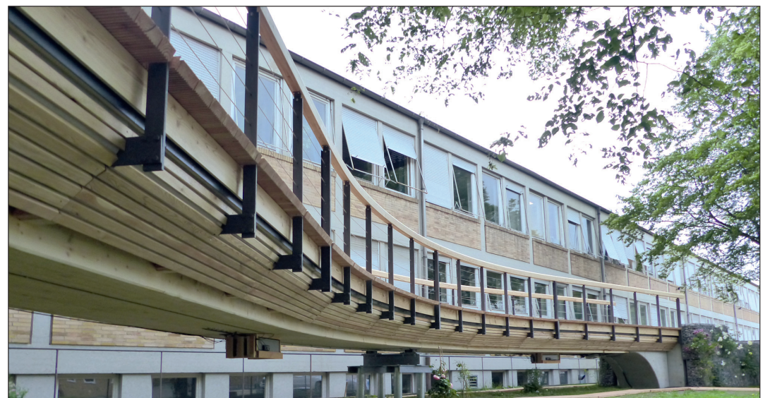
... und die rechte Seite mit dem vor Ort gegossenen Stahlbeton-Widerlager (mit biegesteifem Holz-Beton-Stoß) und einer angeschütteten, mit Gabionen abgestützten Rampe.
