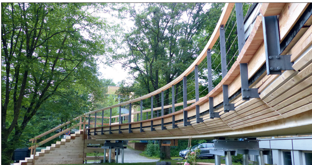
Die »Stuttgarter Holzbrücke« in ihrer schlichten Schönheit, hier die linke Seite mit auskragendem Trägerende und einer (aus Platzgründen) rechtwinklig angeschlossenen Treppen-Podestkonstruktion ...
