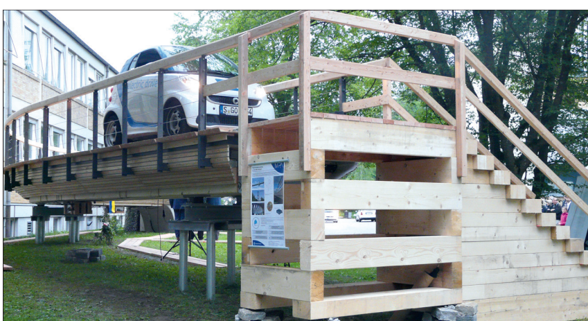
Vorschlag für ein naturfreundliches Brückenlager mit Einschraubfundamenten (links neben dem Podest), was z.B. in empfindlichen Uferzonen sinnvoll sein kann.
